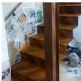
Escada Aço Corten
